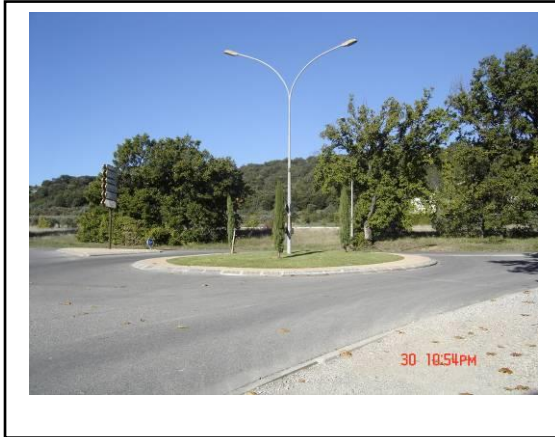
La zone du future giratoire sur l'ancienne RN 96
